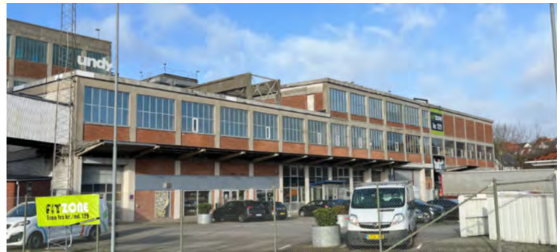
Oprindelige fabriksbygninger anvendes allerede i dag til nye formål.
